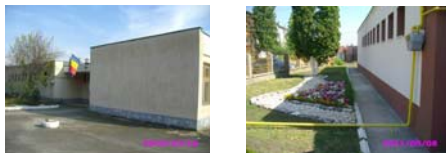
Fig. 9, 10 Aspect general fațadă principală (înainte și după reabilitare)
