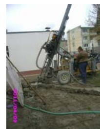
Fig. 7, 8 Aspect injectări la baza chesoanelor
