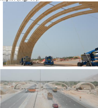
Fig. 19 Imagini de la instalarea structurilor metalice
