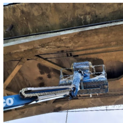
Reparații locale betoane
