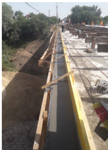
Refacerea consolelor de trotuar
