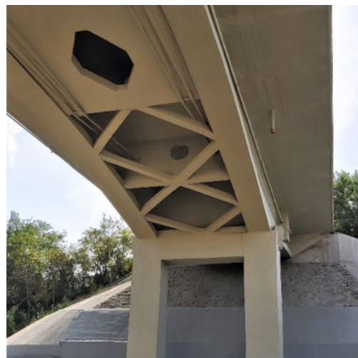
Aspect final al podului după reparații
