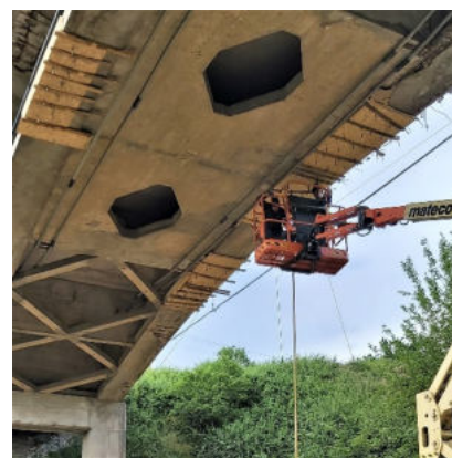
Injectare mortar de monolitizare
