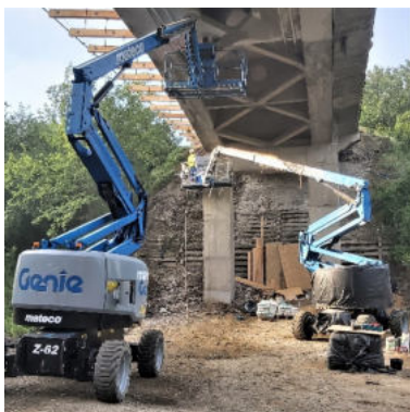
Reparații locale betoane
